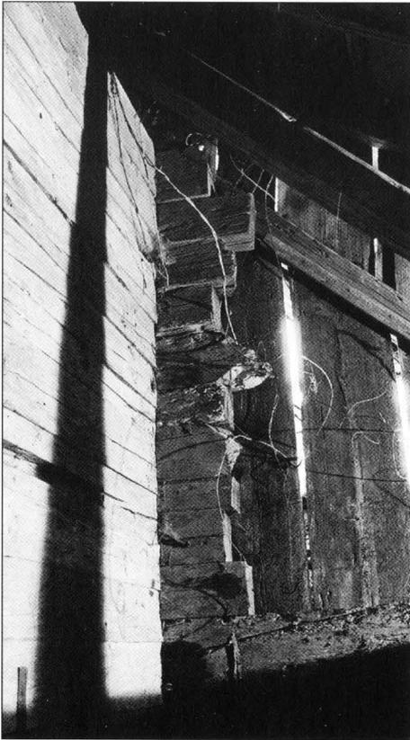
*Die vorstehenden und abgeschroteten Balkenenden der Blockbauweise umschliessen den eigentlichen Wohntrakt innerhalb der Gebäudehülle.*
