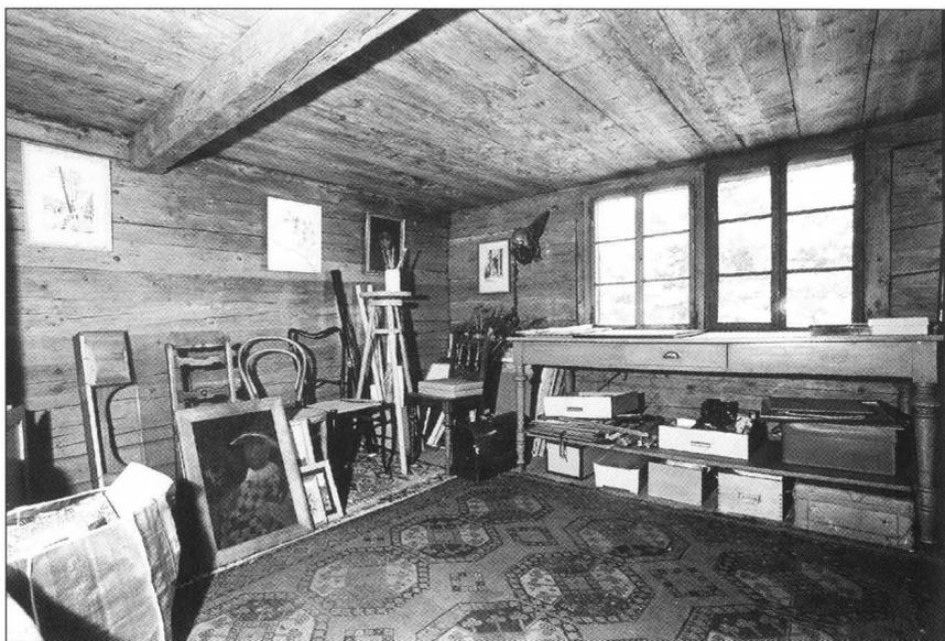
*Die oberste Kammer des Hauses. Sie ist im Innenausbau noch weitgehend im Originalzustand. Sowohl Decke, wie Boden und Wände sind mit breiten, massiven Holzbrettern erstellt.*
